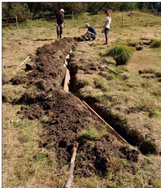
Fig. 9. Allestimento dello sbarramento rudimentale per rallentare il deflusso, 10/9/2021.
